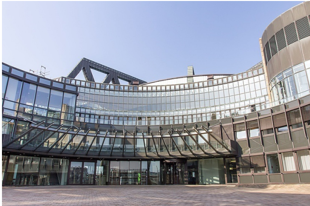
➤ Neufassung der nordrhein-westfälischen Bauordnung in Kraft getreten
